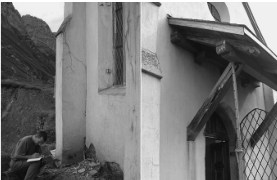
Risse im Stützpfeiler und mangelhaft konstruiertes Dach.
