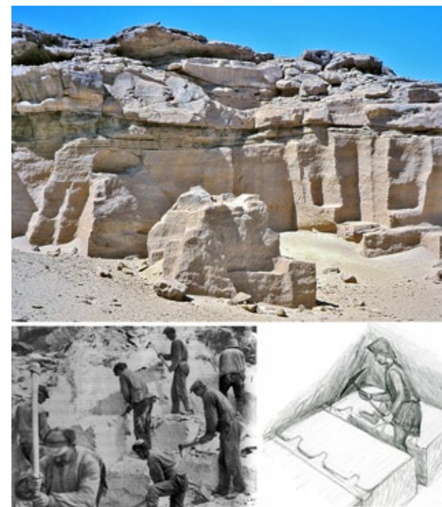
Figur 14. Brytningsteknikk: Kanalhugging har vært brukt til å bryte myk stein i 5000 år. Over: Middle Kingdom (2040-1640 BC) "trappetrinnsbrudd" i Gebel el-Silsila, Egypt. Foto: P. Storemyr. UV: Hugging av blokker i kleberstein i Gudbrandsdalen i 1932. Foto fra Voldheim 1995. UH: Rekonstruksjon av kanalhugging i grønnskiferbruddet på Øye. Horisontale innhugger er kilehull for å løsne blokk langs kløven. Illustrasjon: N. Lundberg. Quarrying technique: Channeling has been used for soft stone quarrying for 5000 years: Top: Gebel el-Silsila, Egypt. Bottom left: Soapstone quarry in Norway 1932. Bottom right: Reconstruction of work in the greenschist quarries at Øye.
