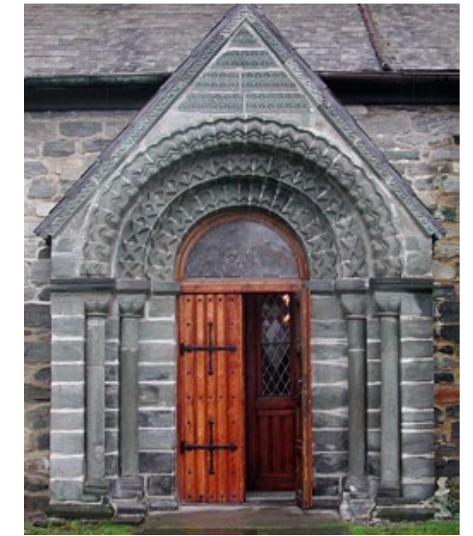
Figur 8. Stavanger domkirke: Grønnskifer fra Ertenstein på Rennesøy i skipets romanske nordportal. Foto: P.Storemyr. Stavanger cathedral: Greenschist at the Romanesque north portal of the nave,
