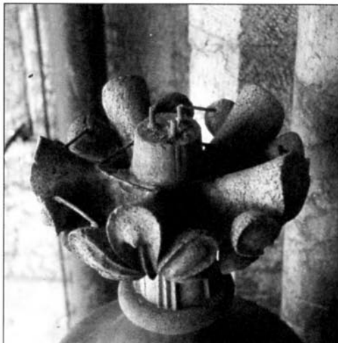
Fig. 2. Korsblomst forsterket med kobberklemmer/dybler i 1920, sørportalen (under restaurering) (Magnussen/NDR)
