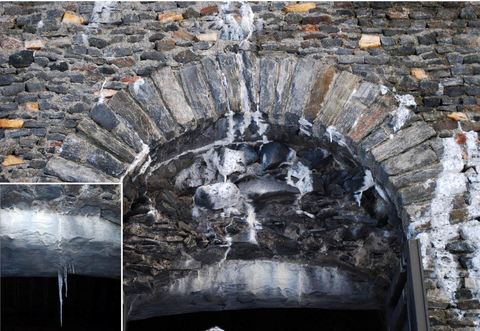
Figur 23: Omfattende kalkskorper i portalen på vestveggen. Disse har blitt dannet suksessivt siden restaureringen i 1913 og er fremdeles "aktive". Det renner vann her i regnvær (se istappen).
