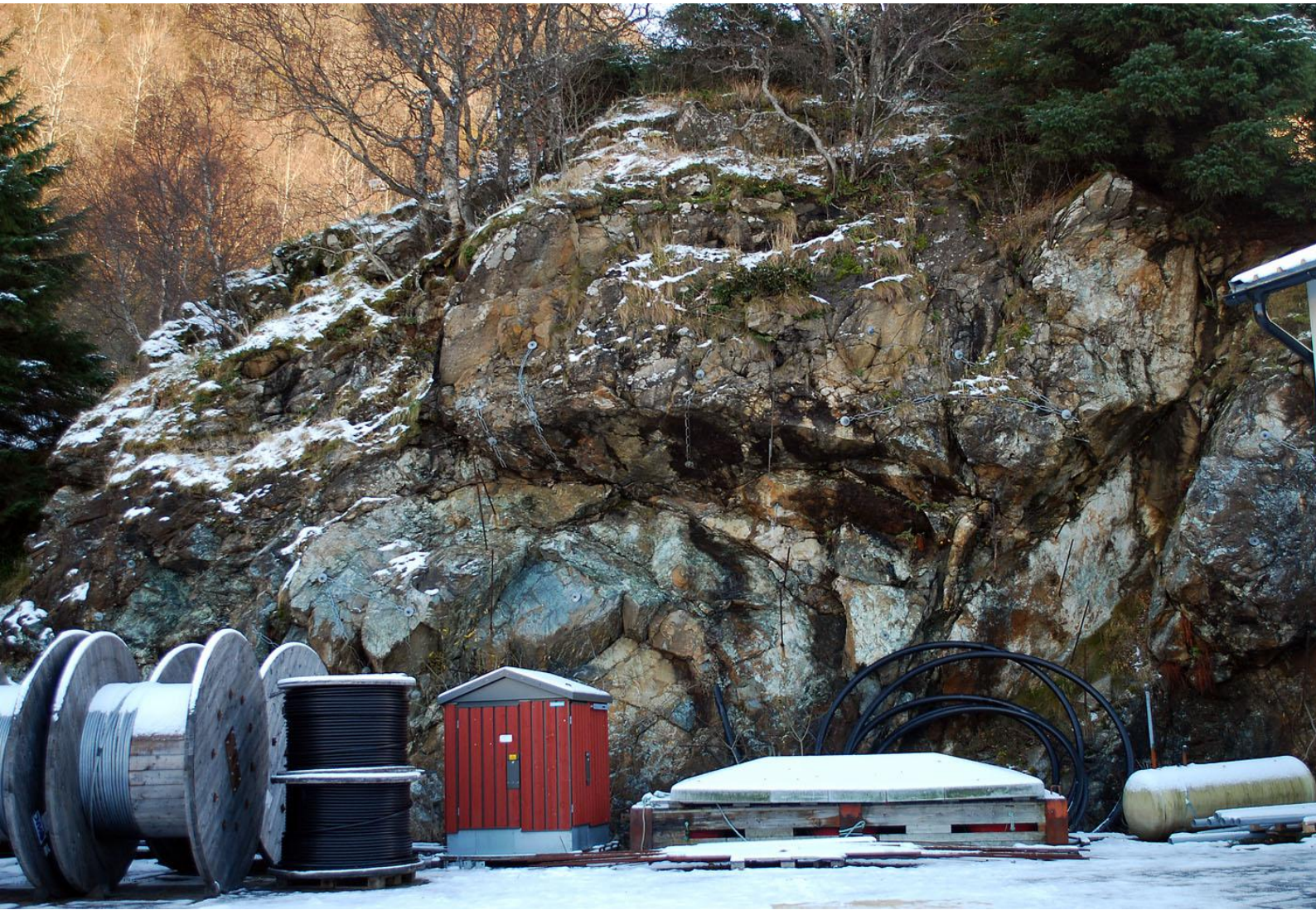
Figur 7: Den største skrenten i olivinsteinens utgående i Deknepollen. Steinen er meget oppsprukket og mange sikringstiltak har vært nødvendige i den senere tid.
