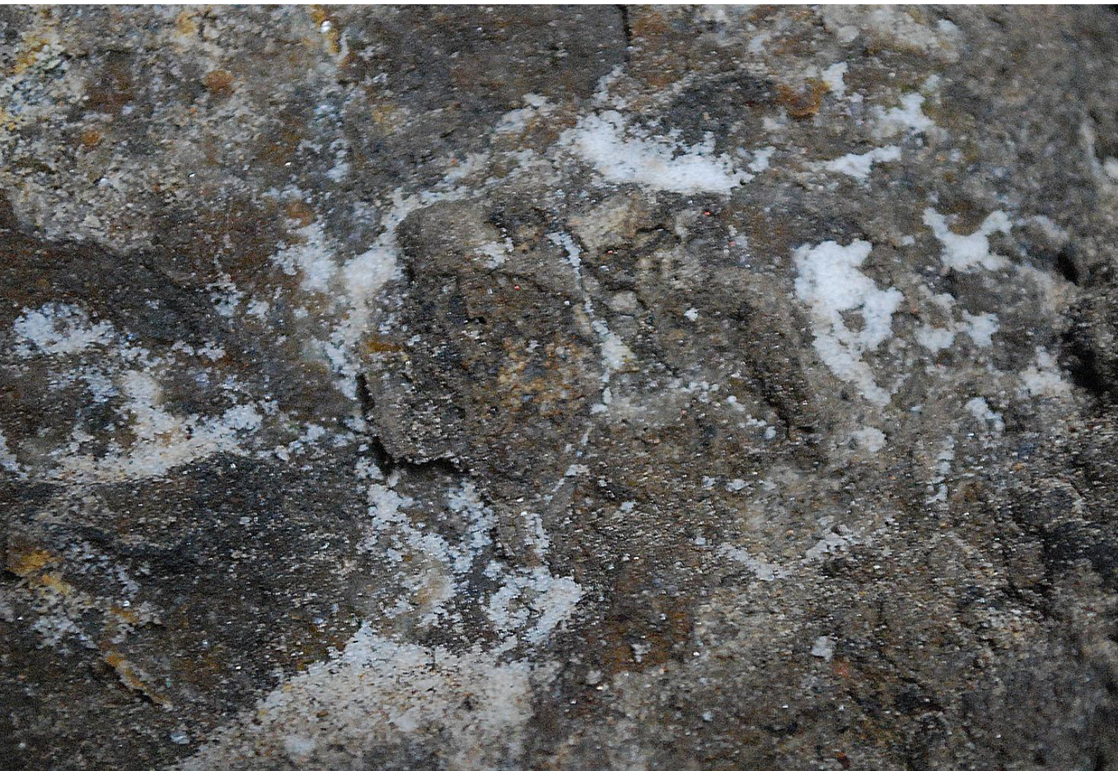
Figur 29: Saltene thenarditt og mirabilitt (natriumsulfater) fører til avskalling av små flak i gneis på tårnets østvegg innvendig. Disse saltene stammer fra bruken av Portlandsement under restaureringene av tårnet. Bildebredde ca. 10 cm.
