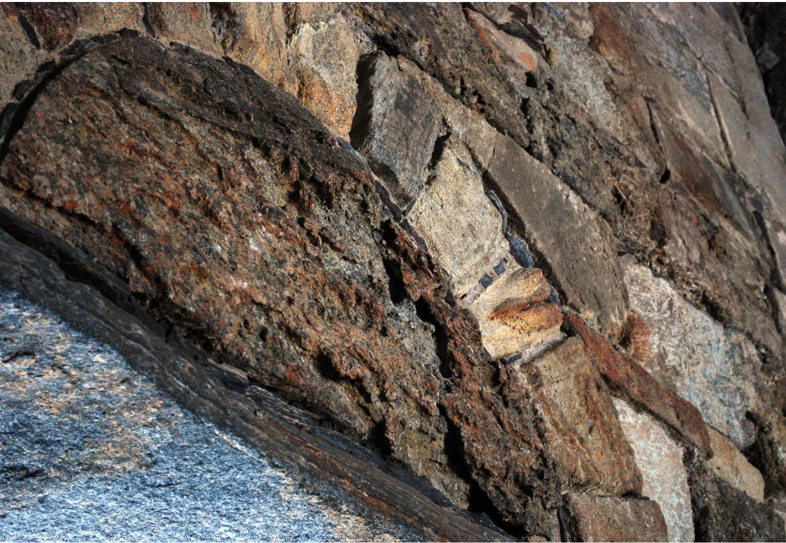
Figur 24: Sterkt forvitret olivinstein på den innvendige delen av tårnets østportal (skipets vestportal).
