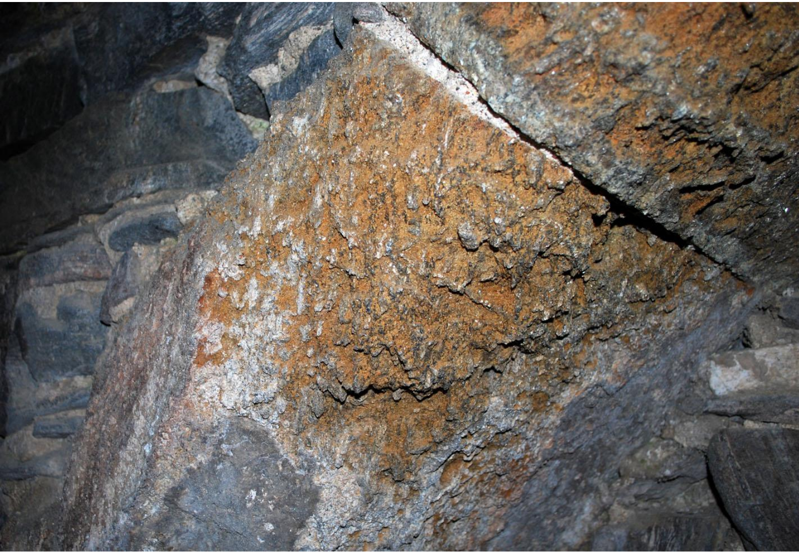
Figur 30: Forvitret olivinstein i buen i tårnets øverste etasje. Legg merke til hvordan nettverket av tynne årer (talk/magnesitt) står frem fra den mer forvitrede "grunnmassen" av olivin.
