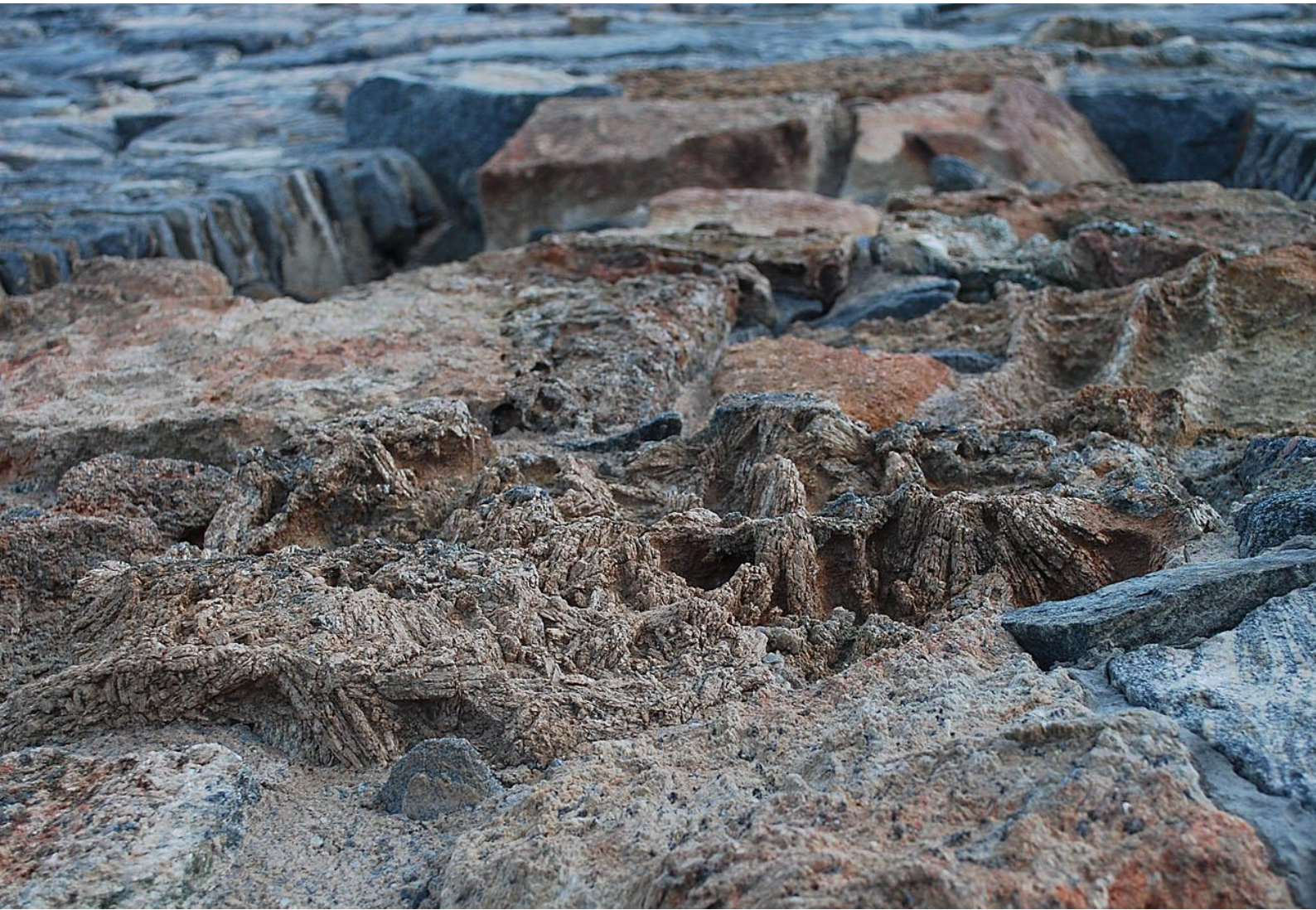
Figur 27: Forvitring av olivinstein på utsiden av tårnets østvegg (skipets indre vestvegg). De grålige "rosettene" består av talk og magnesitt - de olivinrike partiene i steinen har forvitret nærmest fullstendig bort.
