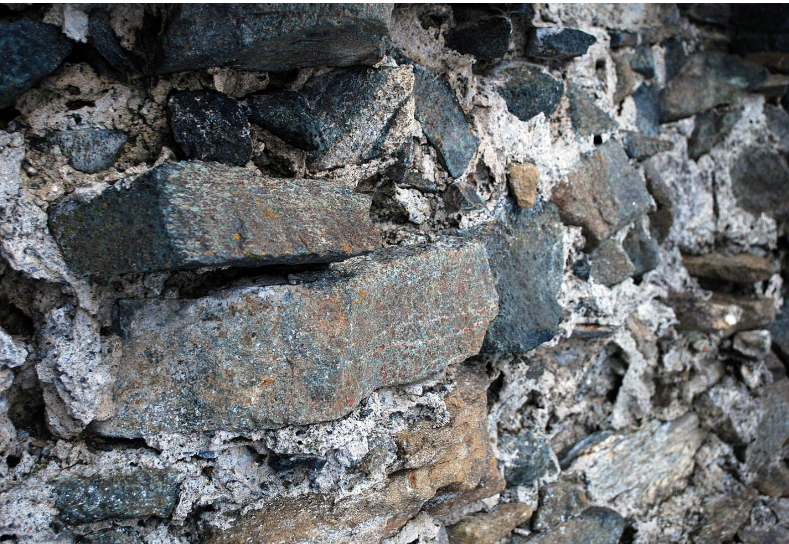
Figur 36: Den ubeskyttede kjernen i skipets nordmur består av "grov" kalkmørtel og store mengder eklogitt.
