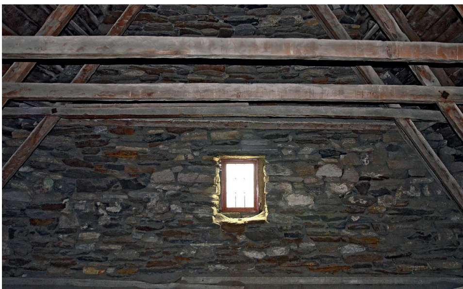
Tverrarmens innvendige gavl fra 1711. Legg merke til at murverket er annerledes, med mindre regelmessige stein enn de middelalderske gavlene. Det er også mye mer mørk stein enn i øvrige gavler. Rødlige stein er for en stor del rustet på grunn av innhold av kismineraler, men noen kan være brente, gjenbrukte stein.
