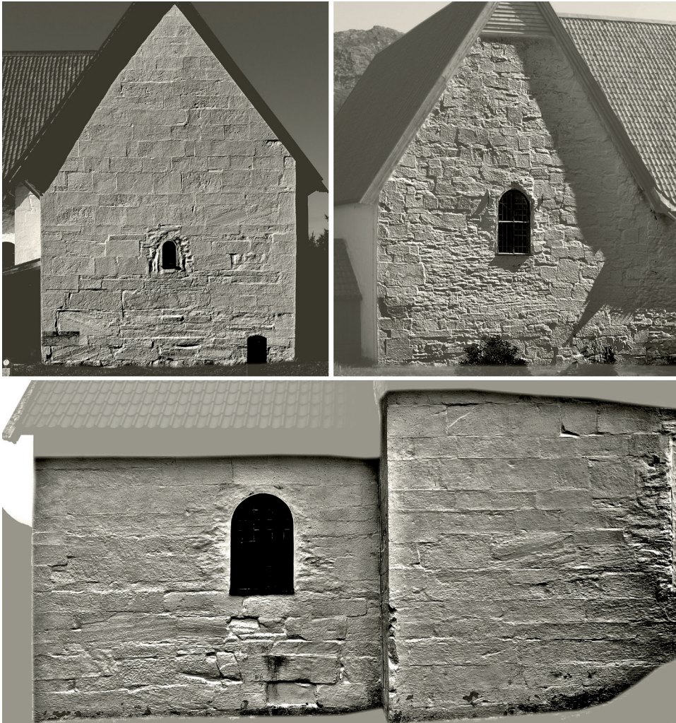
Manipulerte foto av utvalgte fasader med hensikt å gjøre murverket bak pussen synlig: Oppe til venstre: Korets østvegg. Oppe til høyre: Skipets vestvegg. Nederst: Korets nordvegg og østre del av skipets nordvegg. Merk den betydelige forskjellen i murverket på fasadene. Fotoene er ikke skalert, manipulering ved Per Storemyr.
