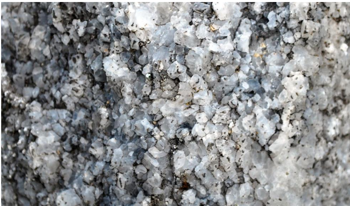
Nærbilde av marmoren som er benyttet til bygging på St. Jetmund kirke i Åheim. Her har marmoren forvitret og står frem som middels- til grovkornet. Foto: Per Storemyr
