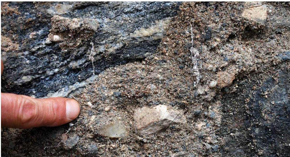
Ubrente marmorbiter i kjernemørtelen i et nylig frilagt parti av Sunnivakirken på Selja. Foto: Per Storemyr
