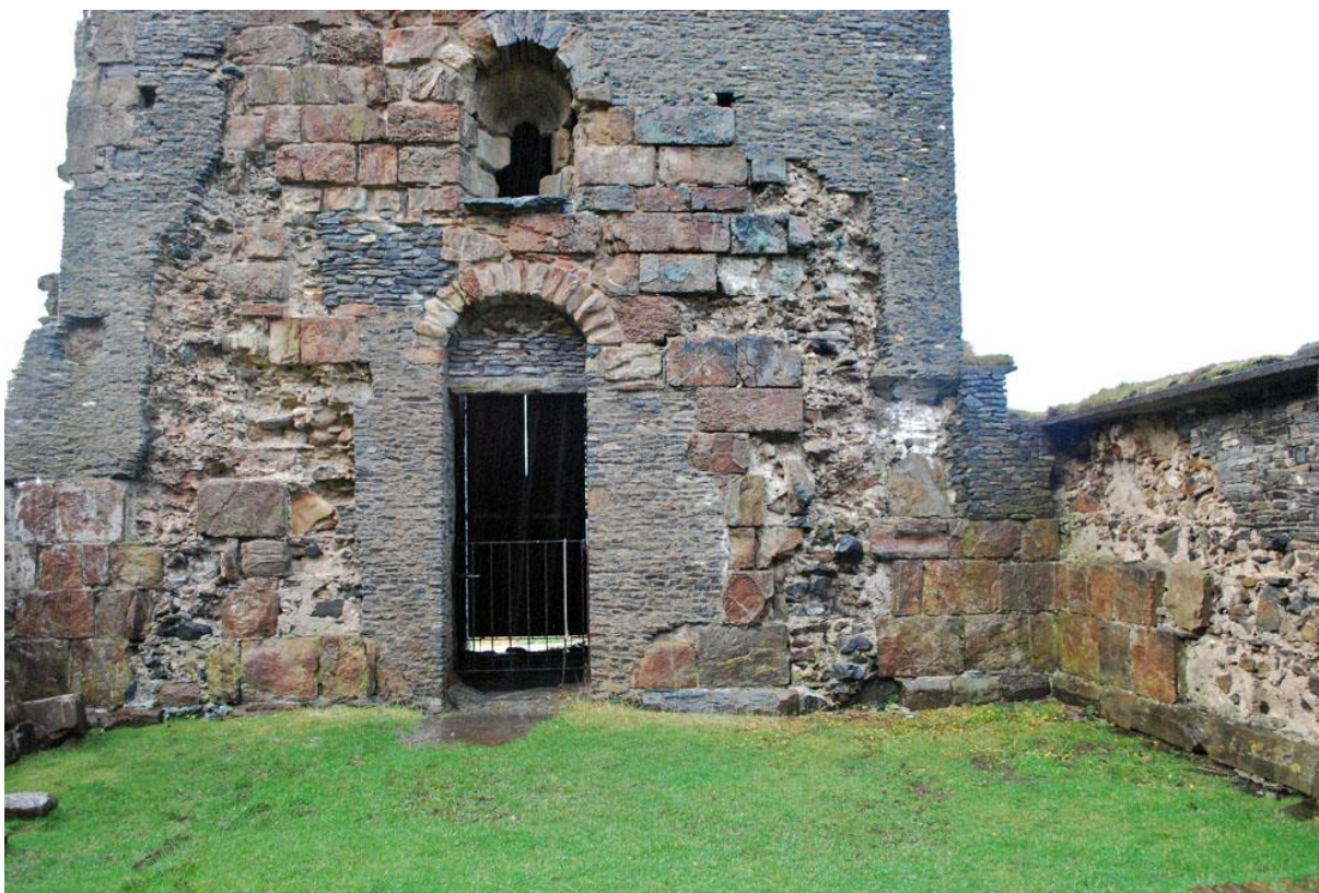
Murkjernene til Albanuskirken og tårnet på Selja er delvis blottlagte. Derfor kan vi få et svært godt inntrykk av hvordan kalk ble benyttet i murene. Foto: Per Storemyr
