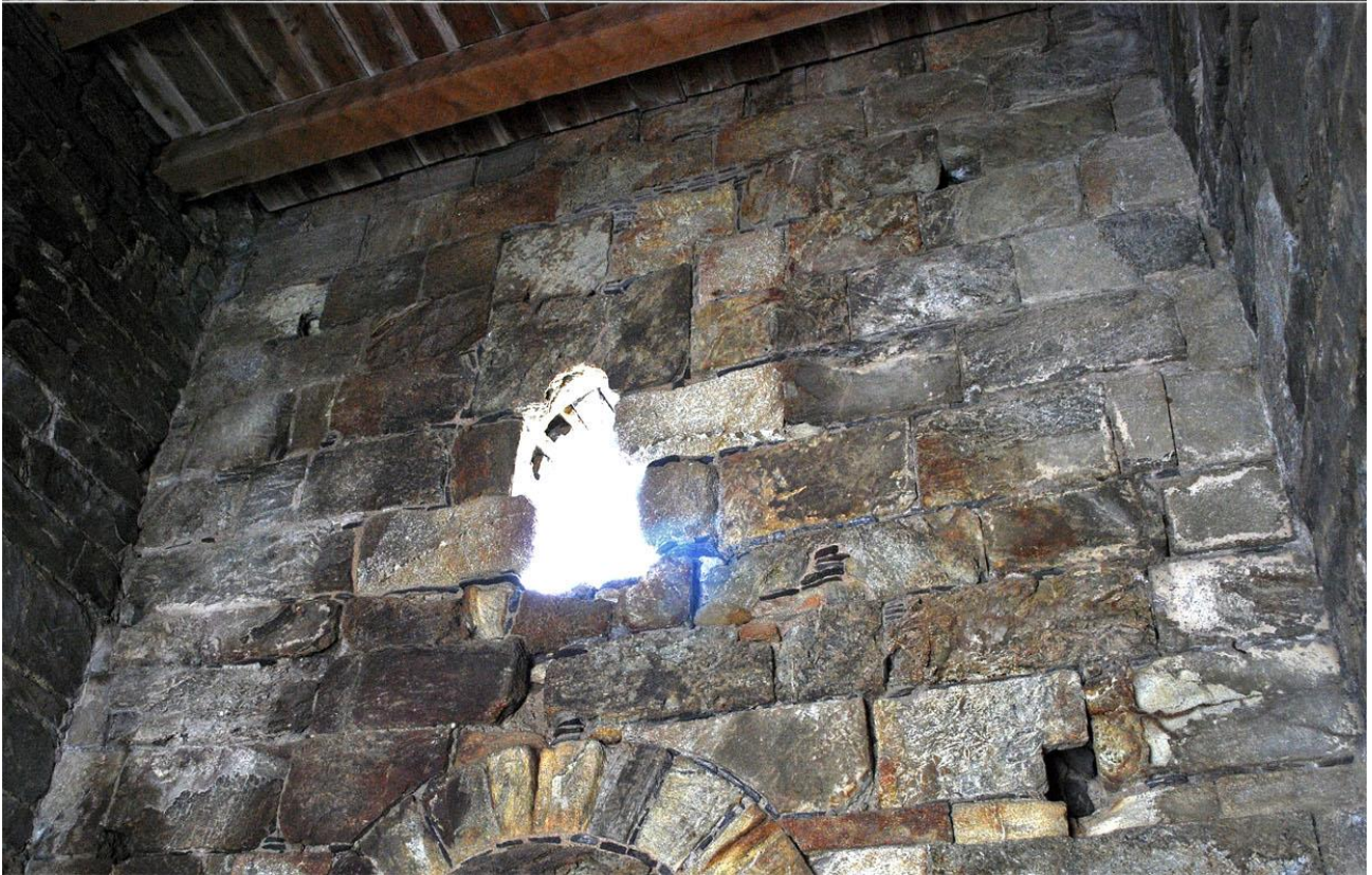
Figur 38: Øvre del av østveggen i første etasje. Foto over er tatt av Egill Reimers i 1912 (Riksantikvarens arkiv). Under foto fra i dag (Per Storemyr). Veggen ble sist restaurert i 2007 til 2010 (se spekking i fuger og nye pinningstein). Alle stein er kvadre i metaolivinstein som generelt har forvitret ganske mye på de mer enn 100 år det er mellom bildene.
