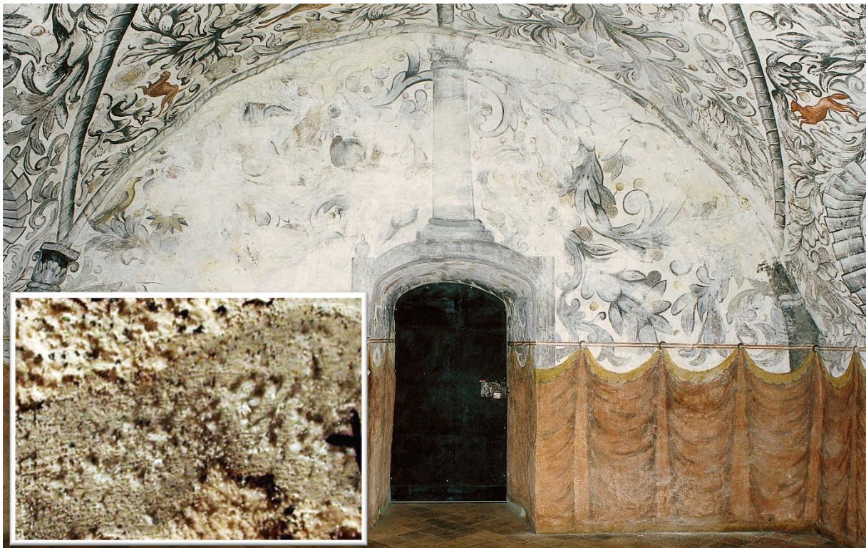
Figur 28: Vestveggen av Regalierommet i Erkebispegården, Trondheim. Foto: Kjartan Hauglid. Innfelt hovedårsaken til at kalkmaleriene fra 1600- og 1800-tallet forvitrer, saltene halitt og natriumnitrat, fra Storemyr 2002.
