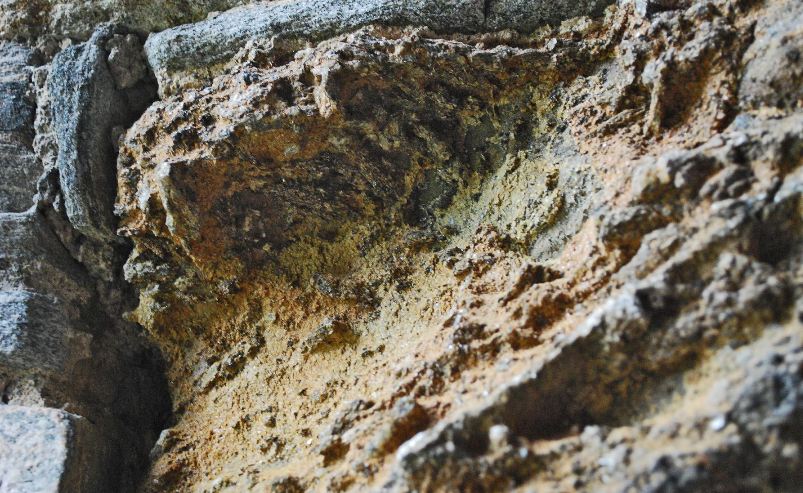
Figur 59: Detaljbilde av sterkt forvitret metaolivinstein i det østre vinduet i tredje etasje i Albanustårnet. Foto: Per Storemyr
