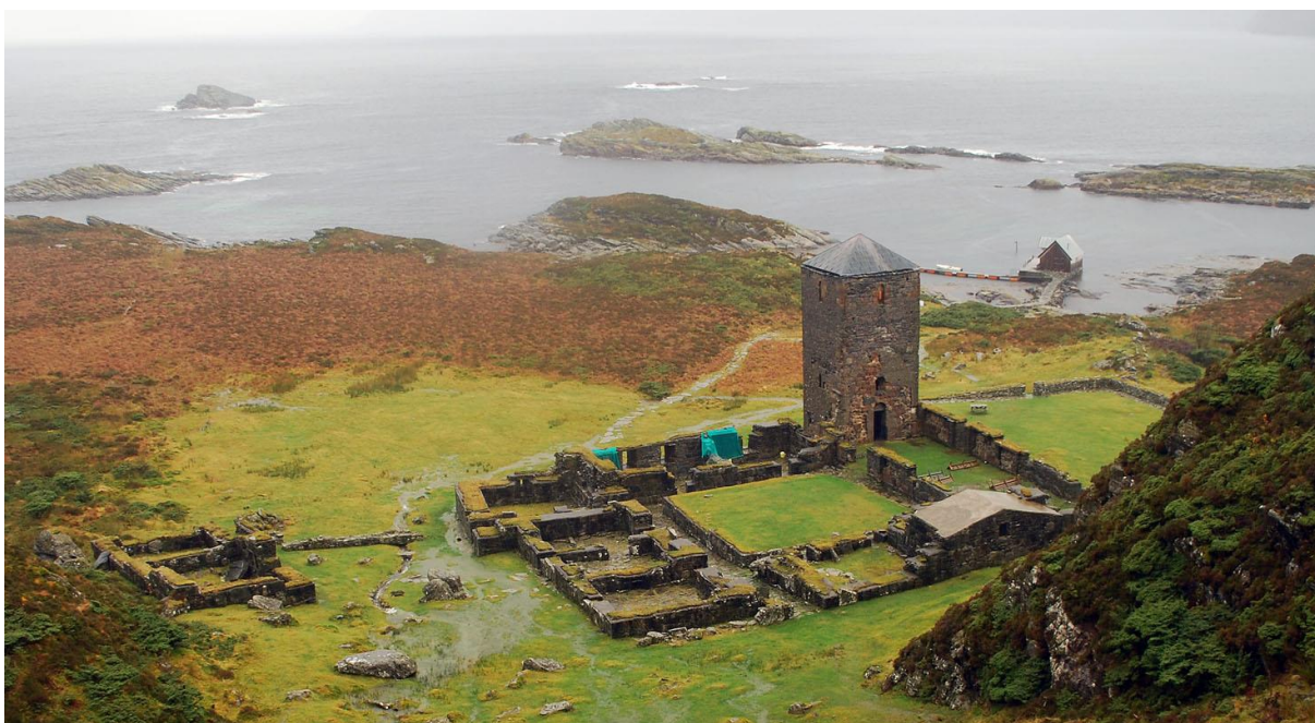
Figur 18: Regn og storm på Selja i november 2010. Fra sjøsprøyt blir det tilført klorid og mindre mengder av bl.a. sulfat til murverket på Albanustårnet. Foto: Per Storemyr.
