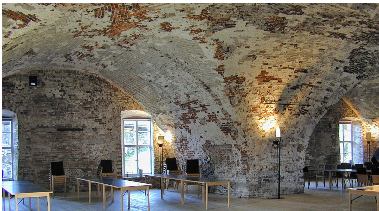
Figur 24 (over): Tenaille von Fersen i Sveaborg. Dekket med salter som ødelegger puss og tegl. Foto: Per Storemyr.
