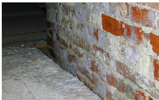
Figur 24 (over): Tenaille von Fersen i Sveaborg. Dekket med salter som ødelegger puss og tegl. Foto: Per Storemyr.
