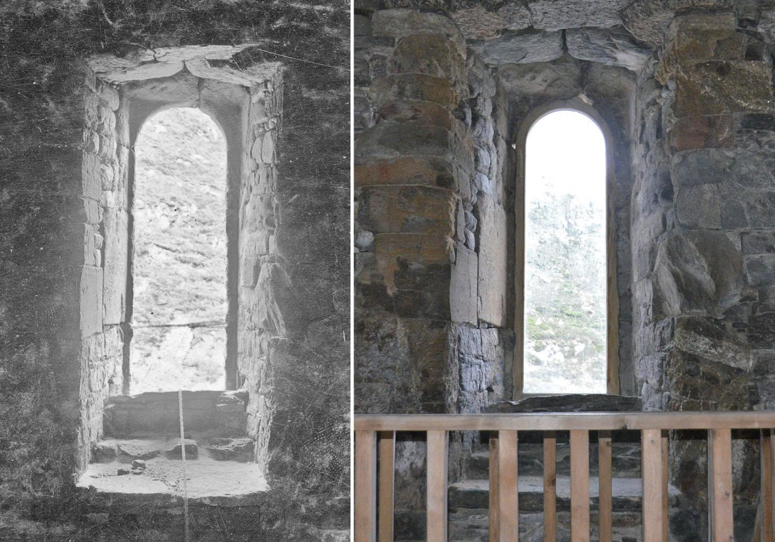
Figur 34: Det søndre vinduet i tredje etasje. Foto til venstre er tatt etter at tårnet kom under tak i 1914 og trolig før 1940 (Riksantikvarens arkiv). Til høyre foto fra i dag (Per Storemyr). Ved detaljstudium av bildene kan en se at forvitringen først og fremst har vært aktiv langs kantene av steiner i de øvre deler av vindussmyget.
