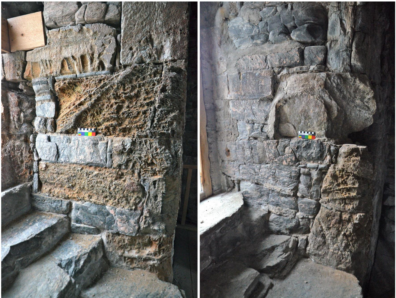
Figur 56: Vindussmygene fra hvilke det ble feid opp nedfalt materiale i tredje etasje. Til venstre det østre vinduet, til høyre det søndre. Vi ser at det østre vinduet har mer metaolivinstein (brun) enn det søndre, som har mye gneis. I det søndre har også fuger blitt reparert med sementholdig mørtel. Som vi ser forvitrer ikke smygene jevnt, det er først og fremst metaolivinstein og fuger som får gjennomgå. Foto Per Storemyr, 12.1.2016.
