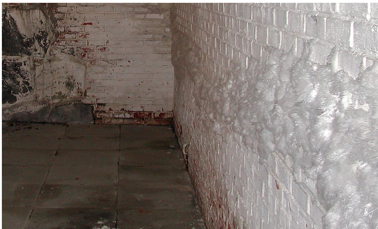
Figur 22 (over): Saltutblomstringer som skjegg: I et stabilt «kjellerklima» kan mirabilitt danne voldsomme efflorescences som ikke nødvendigvis skader murverket mye. Her fra Lavetthuset i Erkebispegården i Trondheim. Foto Per Storemyr.
