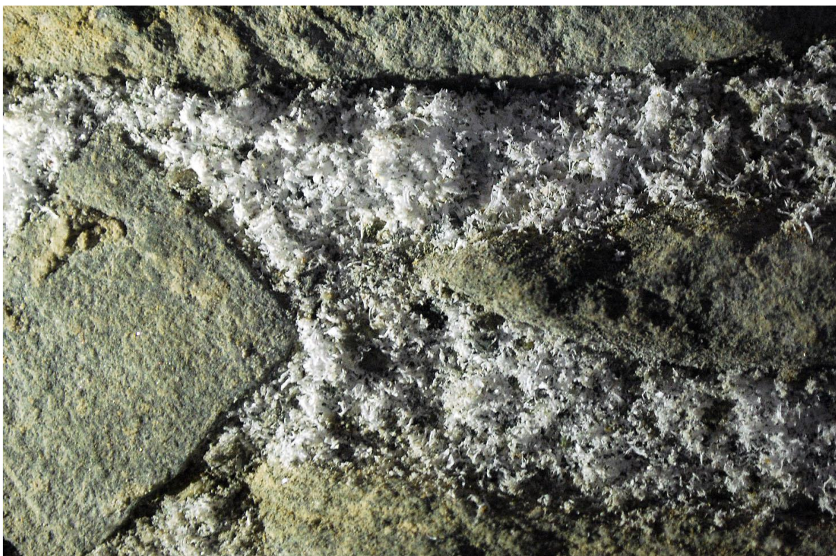
Figur 44: Saltutblomstringer i form av «whiskers» og nåler, natriumkarbonat. Foto: Per Storemyr.
