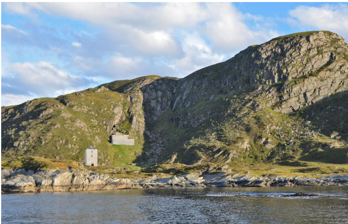
Figur 83: Et mulig framtidsscenario med et hvitkalket Albanustårn. For anledningen er også terrassen ved Sunnivakirka kalket. Foto og illustrasjon: Per Storemyr.
