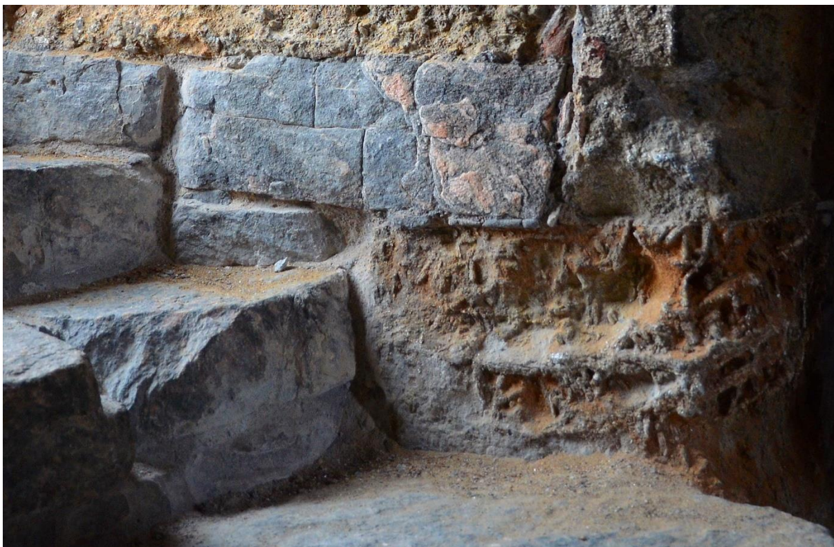
Figur 3: Pulver falt ned i vindussmyget i det østre vinduet i tredje etasje sommeren 2016. Vi ser at metaolivinsteinen (brun) forvitrer mest. Dette stdet er valgt ut for overvåkning av materialnedfall. Foto: Per Storemyr.
