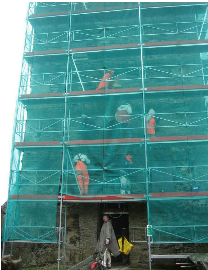
Figur 32: Fra konserveringsarbeidene på tårnet i mai 2007. Foto: Åse Bitustøl, Riksantikvarens arkiv.
