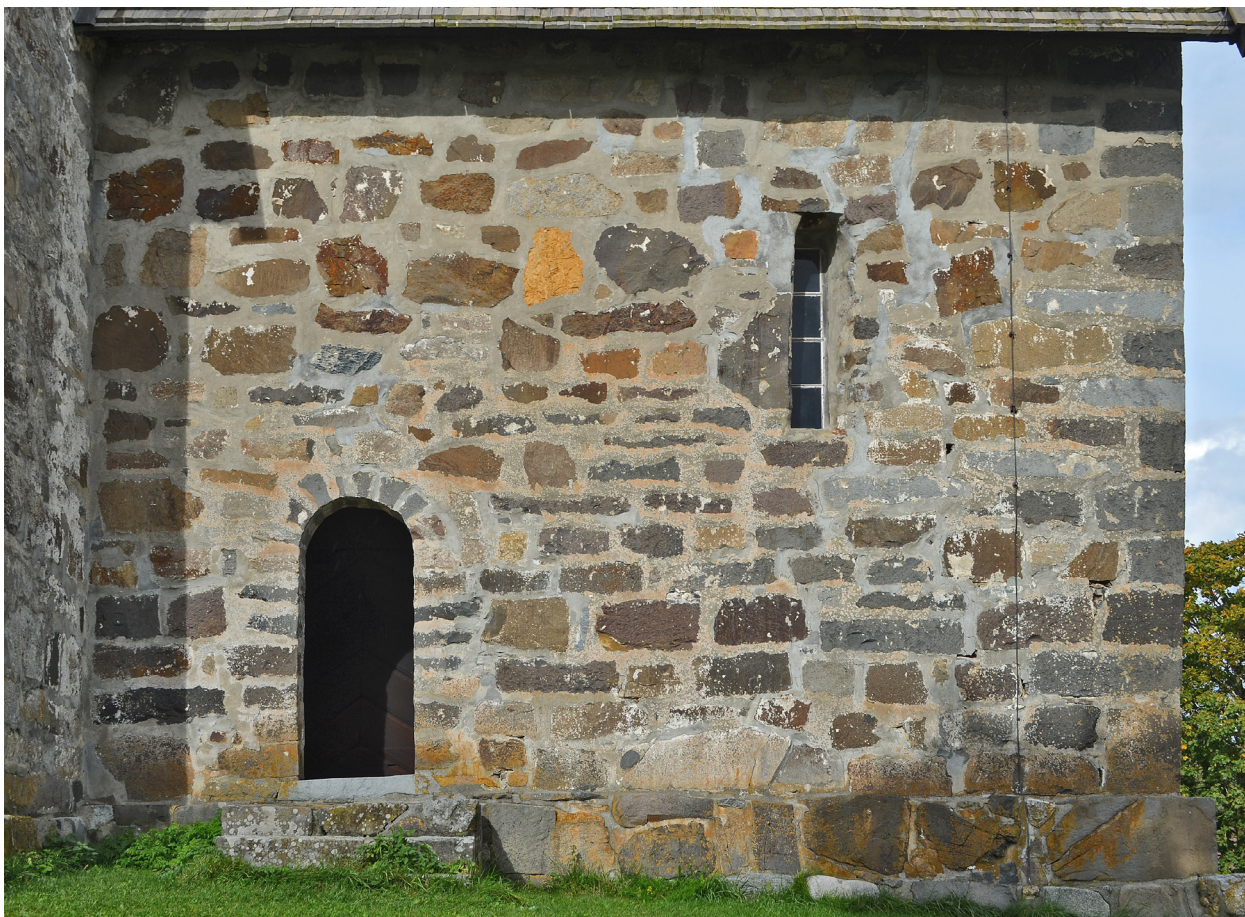
Fig. 13: Korets sørvegg. De nedre delene framstår med ganske regelmessig murverk, de øvre delene er mer uregelmessige. Muren består i stor grad av diabas og mænaitt, men det finnes en del ortocerkalkstein blant steinene med brunlig forvitret overflate. Foto: Per Storemyr.
