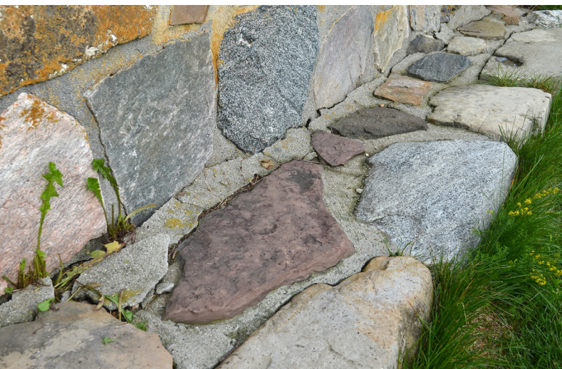
Fig. 9: Den framstående sokkelen på skipets søndre side. Vi ser ulike typer gneis med avrundede kanter og hjørner, noe som viser at de er istransporterte. Den røde steinen i midten er Ringerikssandstein. Foto: Per Storemyr
