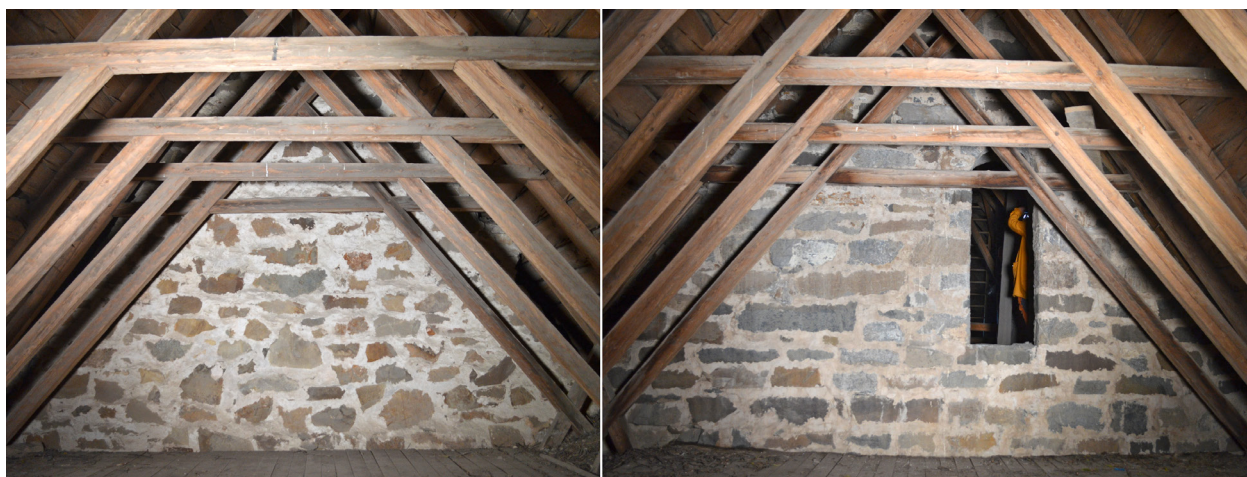
Fig. 7: Opprinnelig middelaldermurverk i korets østgavl (t.v.) og østsiden av skipets østgavl. Vi ser tydelig forskjellen mellom det irregulære murverket basert på vulkanske steiner til venstre og det mer regulære murverket basert på ortocerkalkstein med tydelige skiftegangar til høyre. Foto: Per Storemyr.
