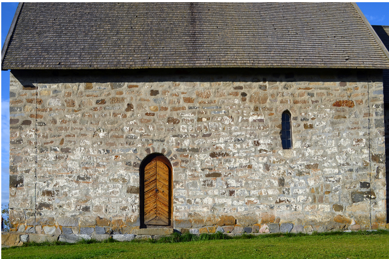
Fig. 10: Skipets søndre fasade. I deler av veggene med mye ortocerkalkstein, er det et nokså regelmessig murverk. Foto: Per Storemyr.
