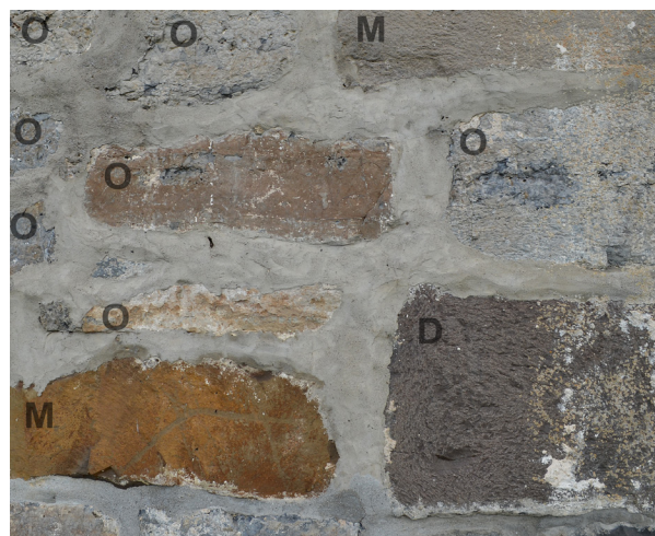
Fig. 12: Detalj av skipets sørvestre hjørne. D=diabas, M=mænaite, O=ortocerkalk. Legg merke til uregelmessige hoggespor på alle de tre typene stein når de er brukt som hjørnestein. Foto: Per Storemyr.
