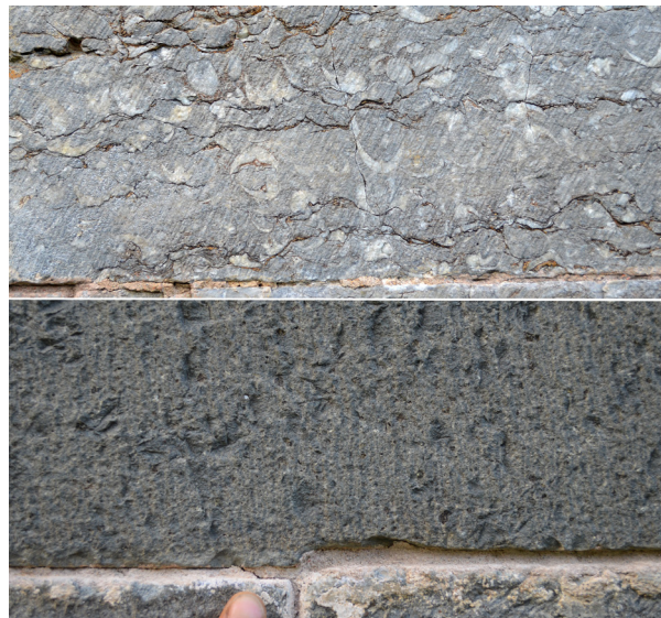
Fig. 14: Kvadre med regelmessige hoggespor på Nikolaikirken (koret). Spesielt på pentameruskalken (over) kan vi ane «tverrstripen», som er et resultat av jevn hogging med breimeisel eller breiøks. Mønsteret er ikke så tydelig på den mørke diabasen. Det er fordi den er mye hardere og fordi små biter har en tendens til å løsne under hogging (negl som målestokk). Foto: Per Storemyr.
