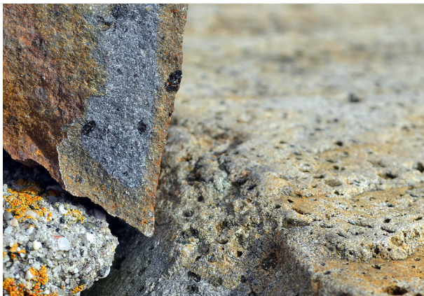
Fig. 19: Detalj av blokk av porfyrisk diabas på Tingelstad gamle kirke (høyre) og spisskantet prøve fra vulkansk gang rett ved kirken (V1 i fig. 17). Det er store likheter mellom steinene. Legg merke til forvitringen og brunfargen i overflaten. Foto: Per Storemyr.
