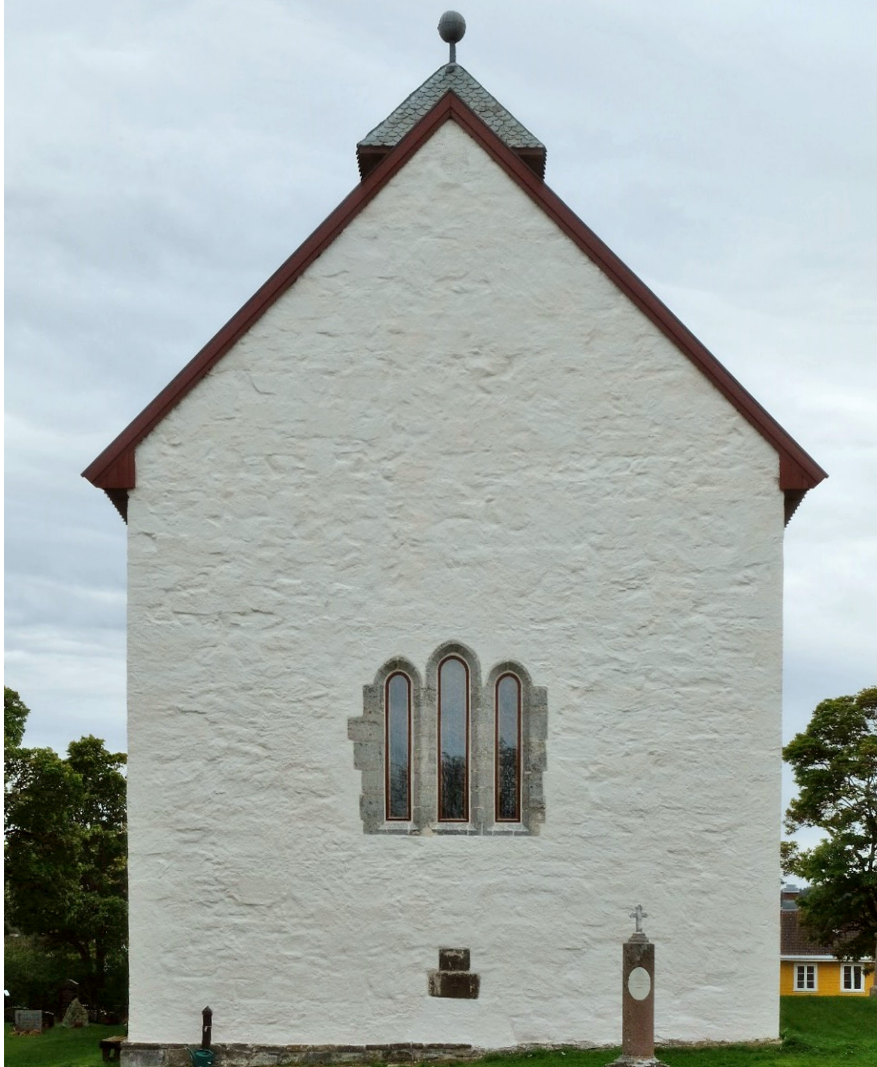
Figur 13: Mariakirken på Gran, restaurert 2022 i hovedsak med «Totenkalk» (Mjøskalk fra Bøverbru), brent i kalkovnen på Helgøya. Foto: Morten Stige.
