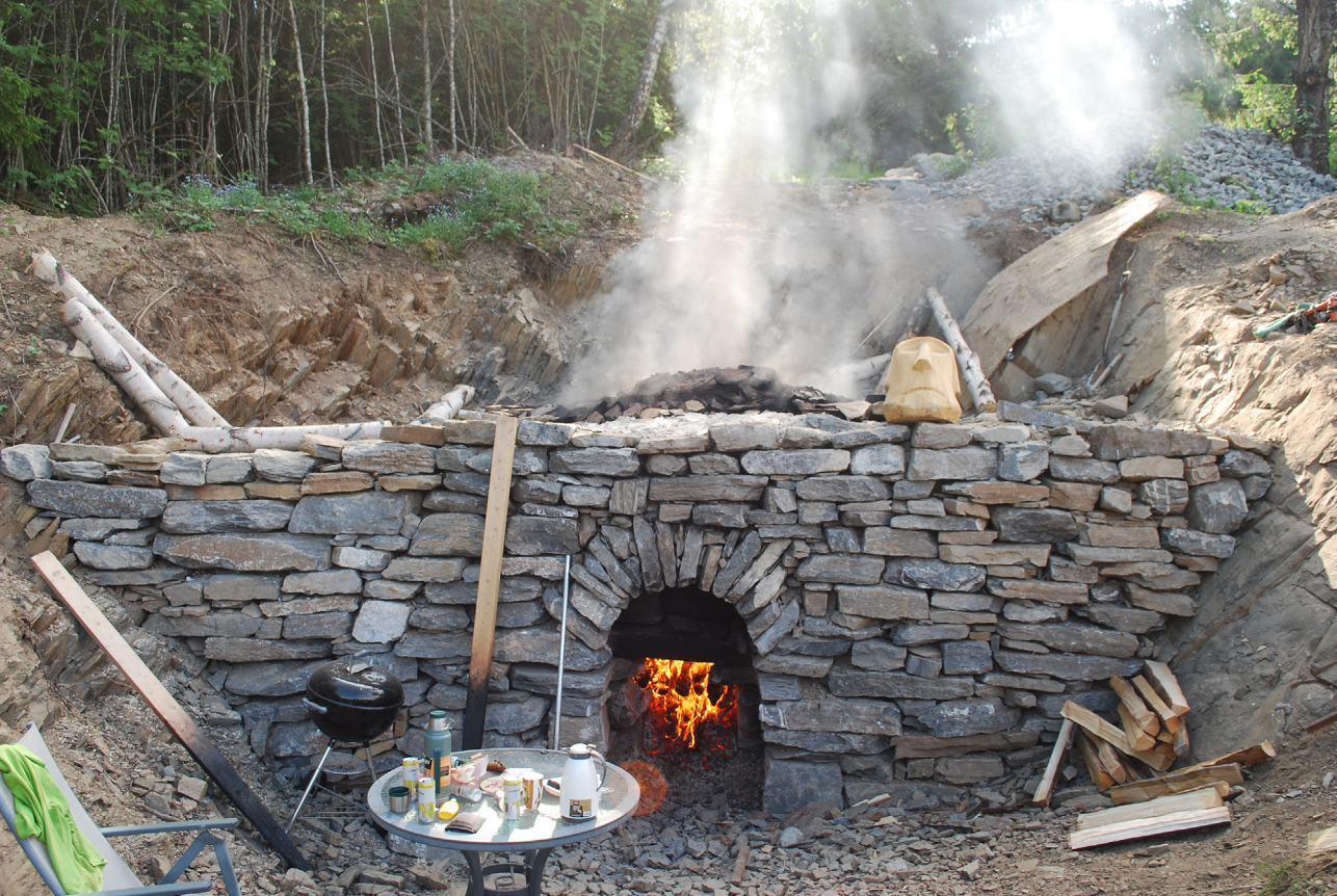
Figur 11: Kalkovnsanlegget til Tore Granmo på Helgøya, bygd i 2021. Den sylindriske ovnen har en kapasitet på ca. 10 tonn kalkstein og er bygd inn i et utsprengt søkk. Foto: Per Storemyr
