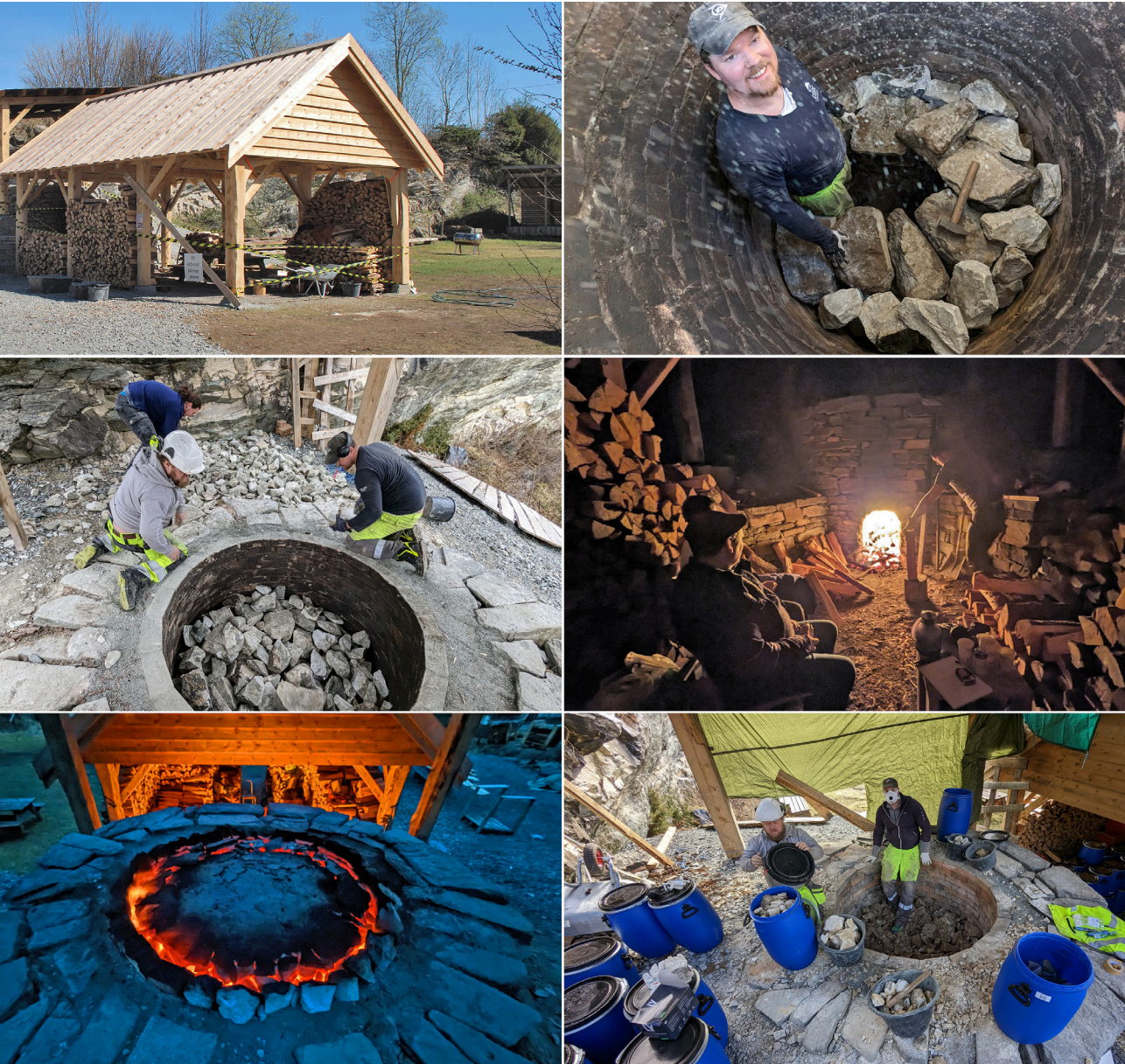
Figur 6: Det nye, tradisjonelle kalkovnsanlegget bygd i 2022 i Mosterhamn på Bømlo, som kurs støttet av Fortidsminneforeningen. Oppe fra venstre: 1) Steinbygd, ca. 8 tonns ovn i bakkant og vedhus/arbeidshus i forkant. 2) Bent Morten Steinsland bygger enkelt hvelv av marmorblokker før brenning. Hvelvet definerer fyrkammeret og er den mest sårbare delen av ovnen, da det utsettes for intens varme og kan kollapse ved feil i byggingen. 3) Fylling med marmorstykker over hvelvet. 4) Brenntiden er drøyt 3 døgn. 5) Glød i ovnen under lokk av leiremørtel for å holde på varmen. Åpning rundt periferien sikrer trekk. 6) Uttak, kvalitetssikring, sortering og pakking av den brente kalken.
