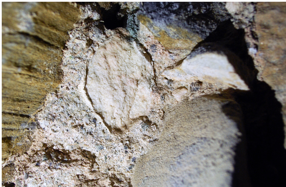
Figur 8: Ofte er det mulig å bedømme råstoffets beskaffenhet ved å studere fuger i gamle bygninger. Her en ubrent «kjerne» av hvit marmor i Moster gamle kirke på Bømlo. Marmoren har den samme karakteren som forekomstene i umiddelbar nærhet til kirken.
