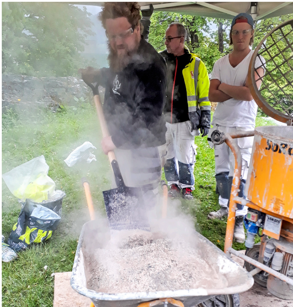
Figur 5: Mørtellesking, eller «hotmix» med brennkalk fra Hyllestad. Det utvikles mye varme ved lesking av kalken i sanden. Vanligvis erstatter man trillebåra og spaden med tvangsblender for å sikre god blanding. Foto: Per Storemyr
