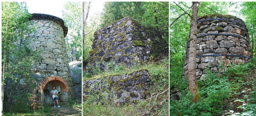
Figur 3: Typiske steinbygde sjaktovner fra overgangen mellom tradisjonell brenning og industri i perioden mellom andre halvdel av 1800-tallet og til litt innpå 1900-tallet. I disse ovnene kunne en brenne både kontinuerlig og periodisk – med steinkull eller ved. Fra venstre: Bergevika (Helgøya i Mjøsa), Bjorvatn (Froland, Agder) og Hovden (Sunnmøre). Foto: Per Storemyr.
