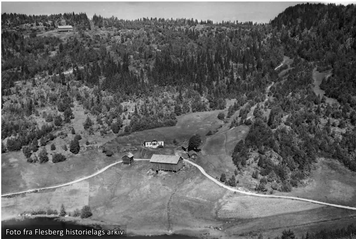
Figur 23: Tilstand i 1959, da det sto en låve nesten oppå lokaliteten, og før veien ble omlagt nedenfor husene (Widerøes Flyveselskap 1959). Kilde: "Dokka Fønsetskogen," Flesberg historielag, besøkt 18. november 2022, https://flesberg.samlinger.no/items/show/10226 .
