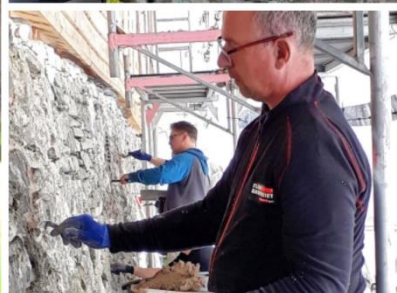
Venstre: Fuger spekkes med Hyllestadkalk! I framkant: Byggherre Åse Tveitnes Høyre oppe: Muren er snart ferdigspekket. Litt finarbeid med den tynne murskeia Høyre nede: Ikke mindre enn 5 hender i gang med å spekke fuger! (Det var mange på baksiden av kameraet også)
