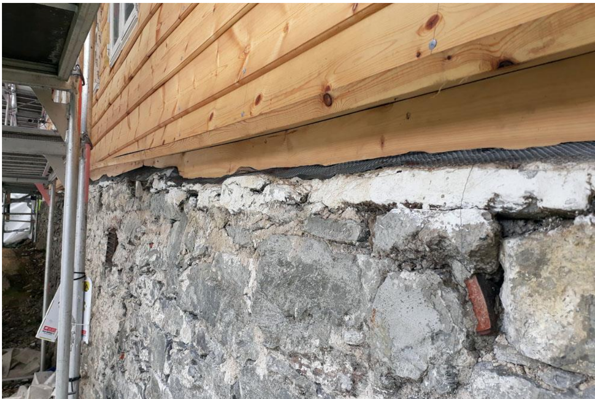
Muren rett før kurset: Restaurert trevegg med vannbord, murkronen restaurert med kalk, innlagt blybeslag og musenetting
