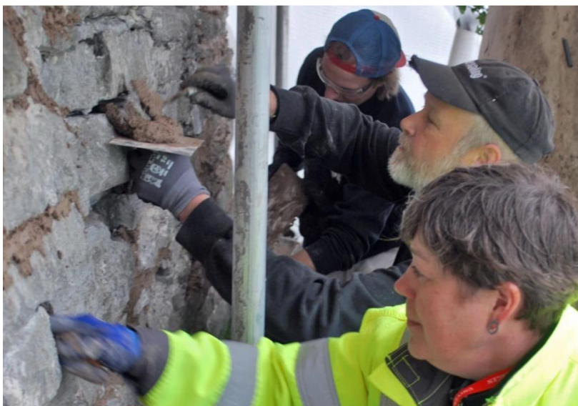
Venstre: Fuger spekkes med Hyllestadkalk! I framkant: Byggherre Åse Tveitnes Høyre oppe: Muren er snart ferdigspekket. Litt finarbeid med den tynne murskeia Høyre nede: Ikke mindre enn 5 hender i gang med å spekke fuger! (Det var mange på baksiden av kameraet også)
