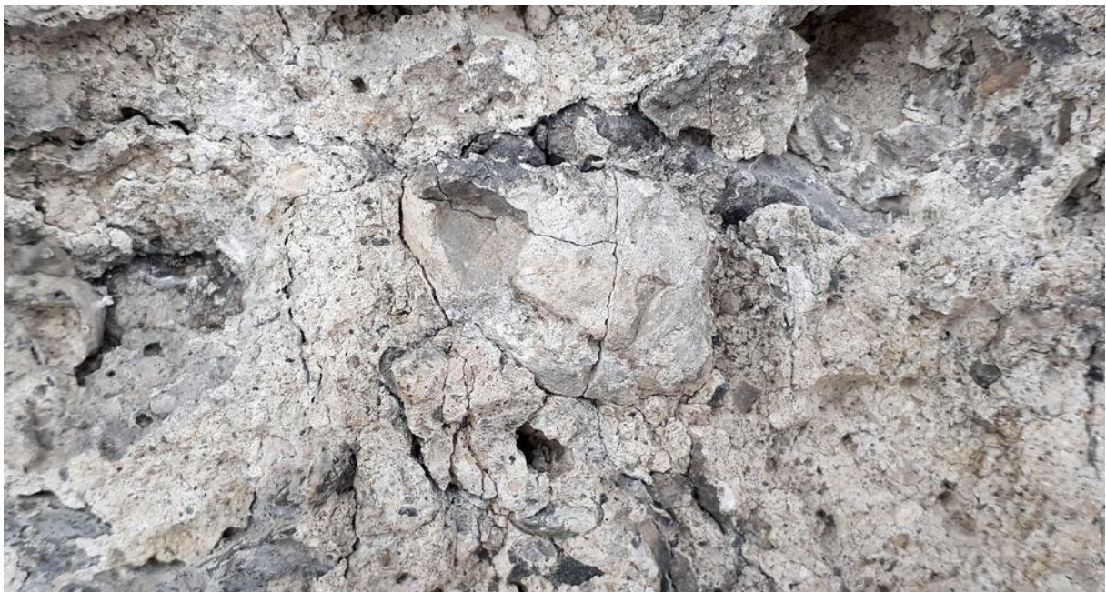
Inntrykk av den gamle kalkmørtelen brukt til fuging og pussing. I midten kjerne av ubrent kalk (ca. 5 cm lang).
