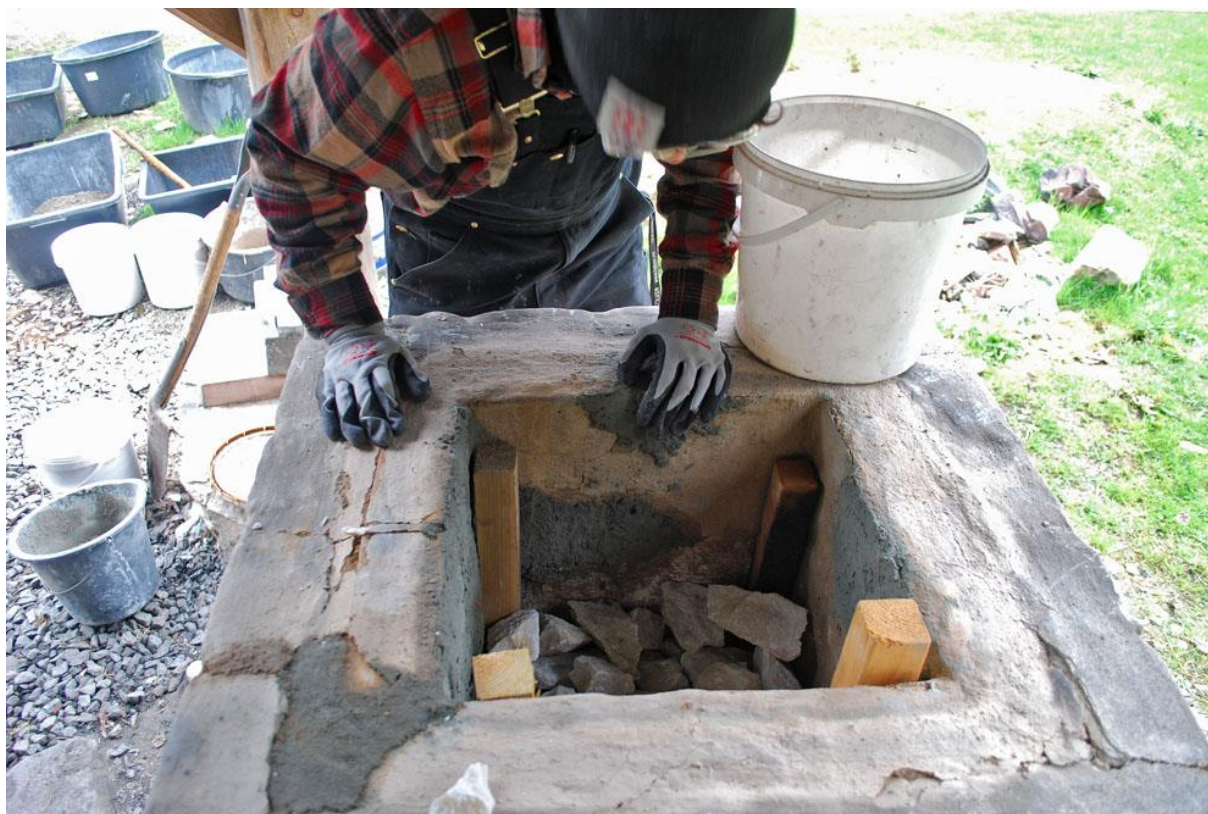
Sverre fyller ovnen med hvit marmor fra Skaftå på Osterøy. Trestokkene blir til trekkanaler når de brenner opp.
