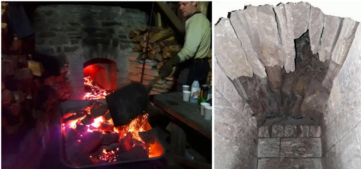
Nedfalte stein og glødende kull spas ut av ovnen etter at brenningen er erklært ferdig. Midt på natten. Deler av steinene i halvparten av hvelvet sprakk opp og falt ned under brenningen.
