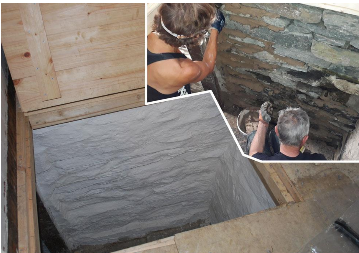
Berit Bruvik og Ove Kyte spekker og kalker den innvendige delen av grunnmuren på Fastings Minde i 2019.
