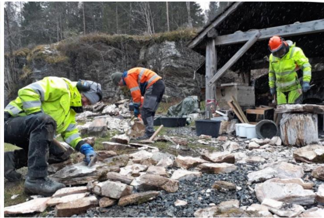
Berit Bruvik, Kjetil Monstad og Haakon Aase i full sving med å bryte ut marmorheller på Nygård i Hyllestad. Senere bearbeider de marmorhellene som skal brukes til brennkammerhvelv i kalkovnen.
