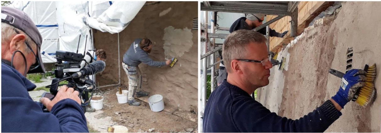
Instruktør Tore Granmo slemmer den første delen av muren, under oppsyn av NRKs kamera ... så går det på med slemming av pussen av alle kursdeltakerne...
