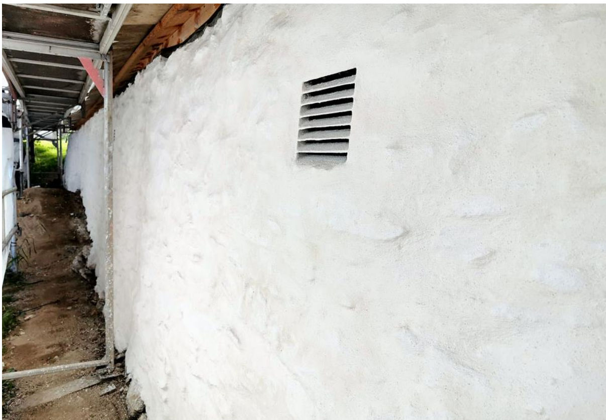
Muren etter fem lag med hvitting av Osterøykalk, de fire siste lag utført etter kurset. Foto: Berit Bruvik
