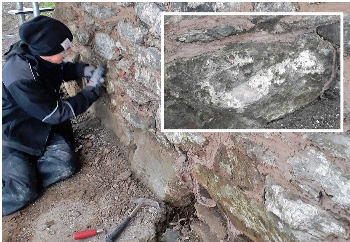
Nitidig vekkskrubbing av grønnalger på steinoverflater. Det innfelte bildet viser at mesteparten lot seg skure vekk.
