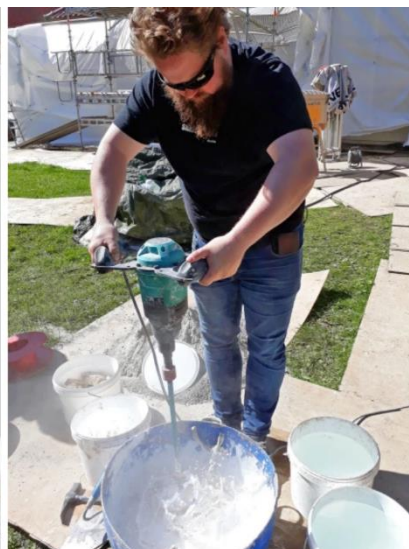
Det syder og koker ved våtlesking av Osterøykalk! Instruktør Tore Granmo blander våtlesket Osterøykalk med finsand
