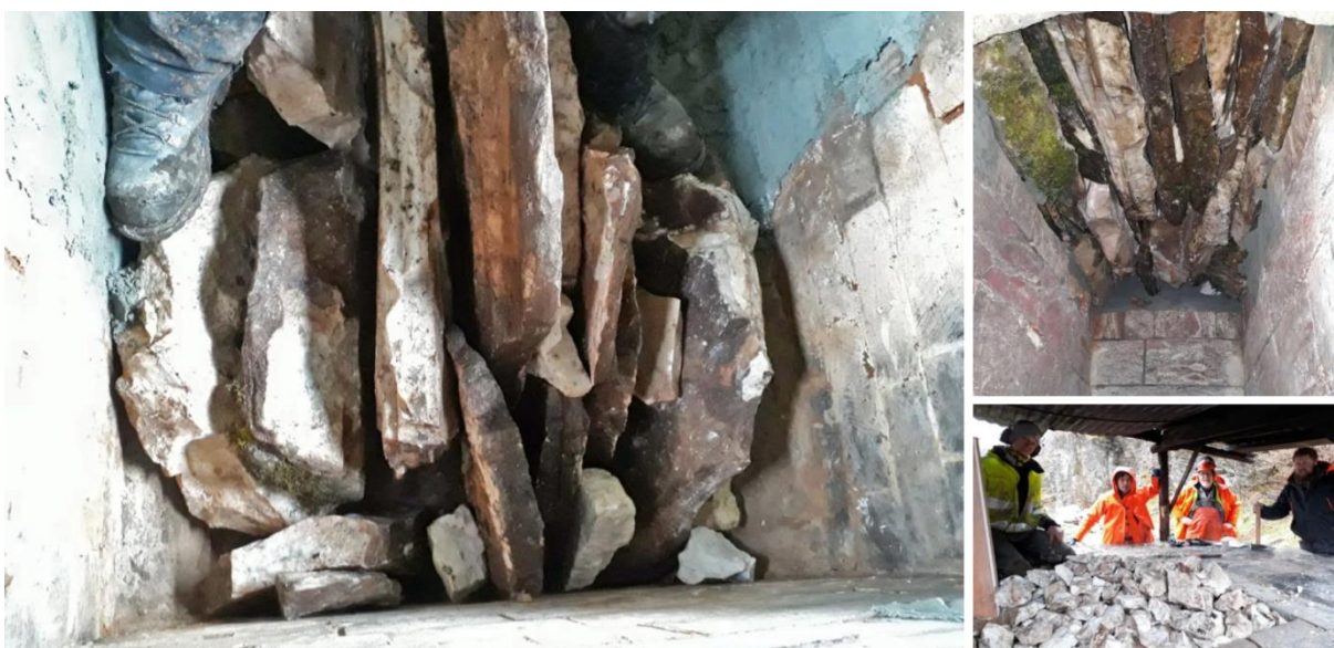
Detaljer av brennkammerhvelvet sett ovenfra og fra undersiden. Senere er ovnen fylt og gjengen er fornøyd!
