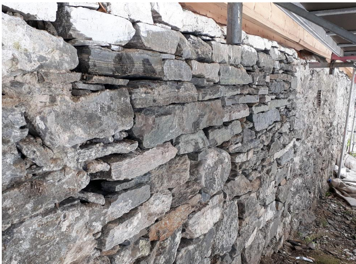
Et svært dårlig parti av muren ble demontert og oppført i tørrmur under ledelse av Haakon Aase i 2019.
