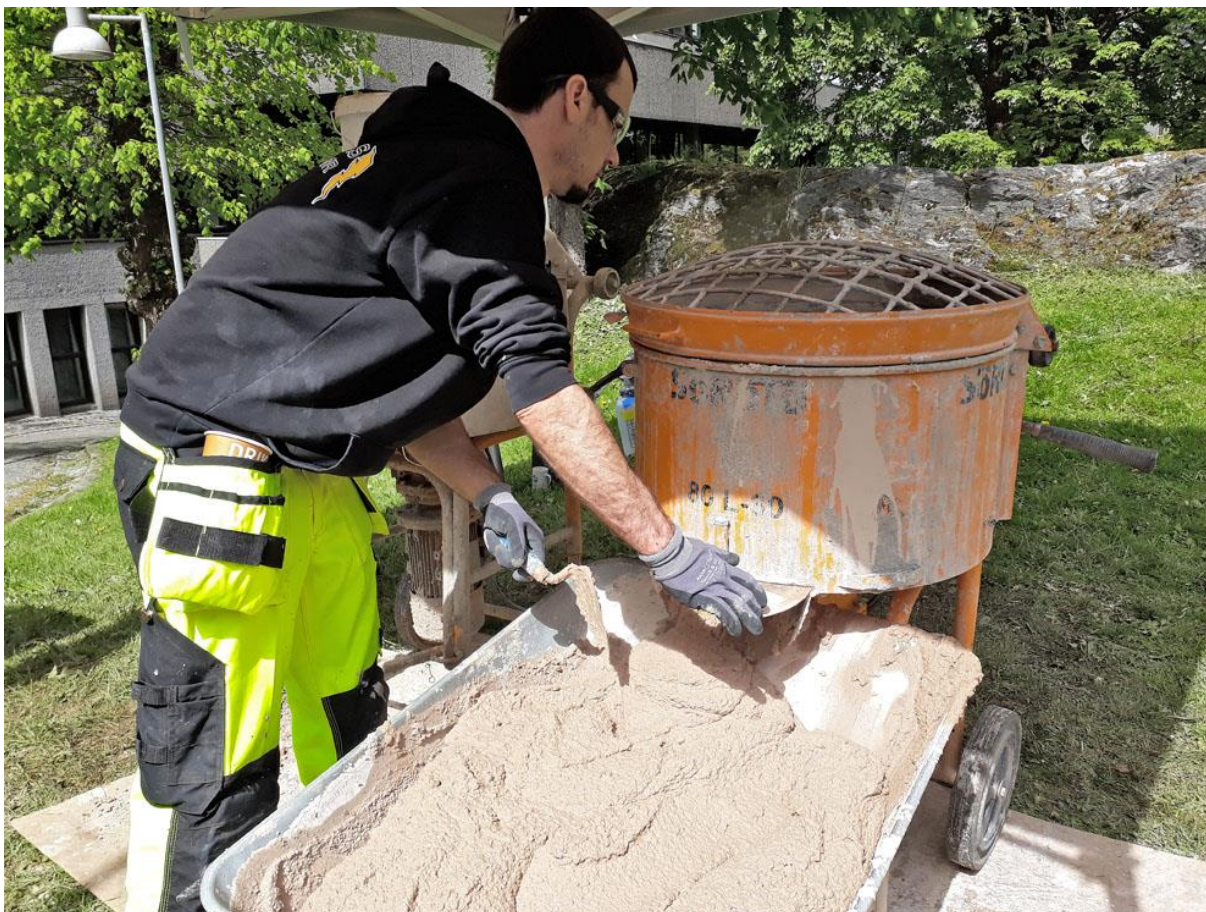
Hotmix til pussing, nokså våt blanding, tas ut av tvangsblenderen – klar til veggen!
