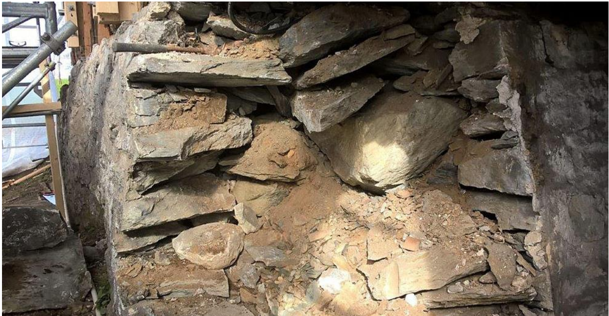
Snitt gjennom muren viser at det er jord i kjernen mellom murskallene. Fra forarbeider i 2019. Foto: H. Aase.
