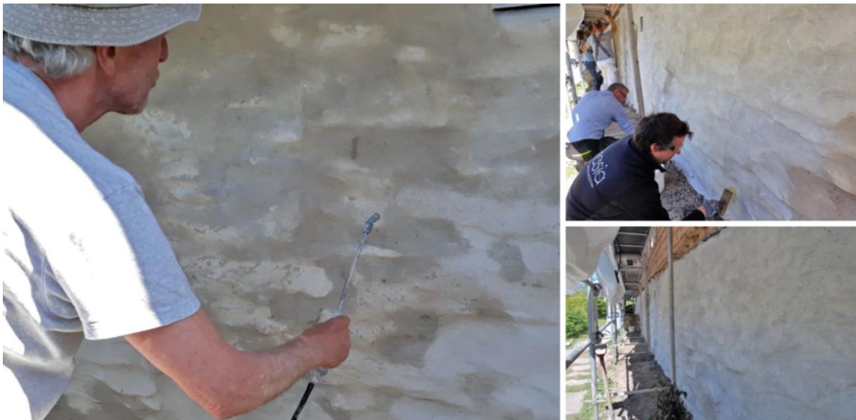
Instruktør Terje Berner er nøye med vanning av muren før hvitting Det første laget med hvitting kostes på muren av alle kursdeltakerne Muren er nokså hvit og fin etter det første laget med hvitting
