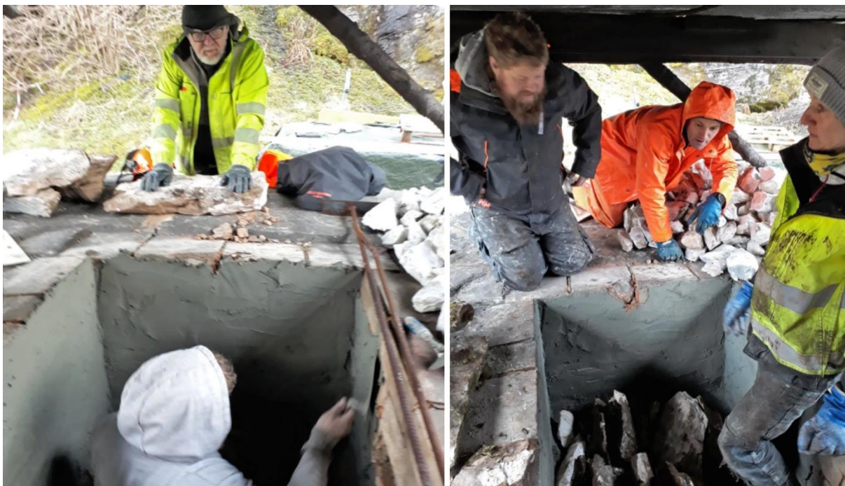
Tore pusser ovnen med leiremørtel for å beskytte murverket mot heten. Haakon følger med. Så diskuteres det hvordan brennkammerhvelvet skal behandles.
