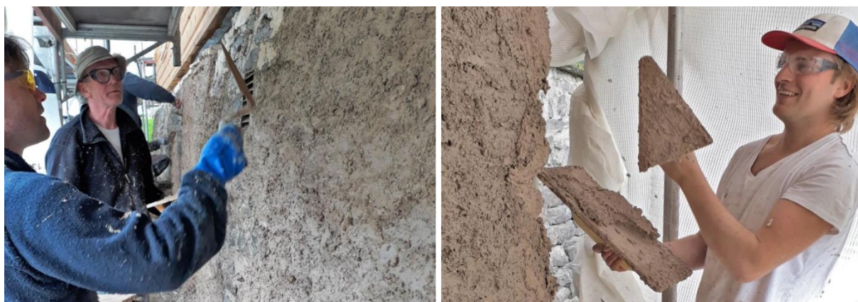
T.h.: Pusspåkast under kyndig oppsyn av instruktør Terje Berner. T.v.: Pusspåkast med et smil! Murerlærling Martin Rebnord Pedersen i sving med Hyllestadkalk under kalkkurset
