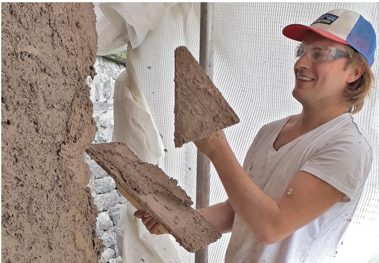
Pusspåkast med et smil! Murerlærling Martin Rebnord Pedersen i sving under kalkkurset.
