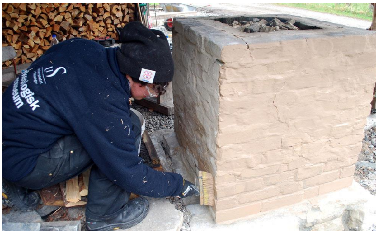
Sverre slemmer ovnen med beige Hyllestadkalk mens vi småfyrer for å tørke hvit Skaftåkalk til brenning.
