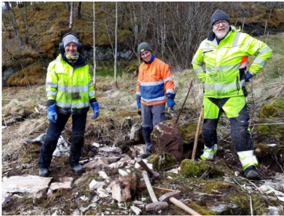
Berit Bruvik, Kjetil Monstad og Haakon Aase i full sving med å bryte ut marmorheller på Nygård i Hyllestad. Senere bearbeider de marmorhellene som skal brukes til brennkammerhvelv i kalkovnen.
