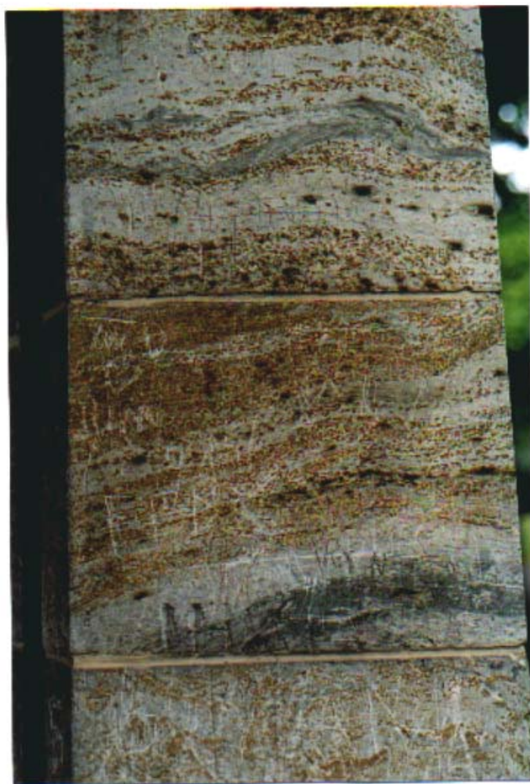
Musikpaviljongen (ca. 1920) rett øst for koret i Stavanger domkirke. Paviljongen har klebersøyler. Kleberen er året med mye karbonat og endel grønne inneslutninger.
