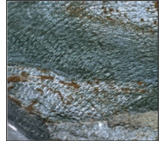
Grov etterhugging av kvaderflater
