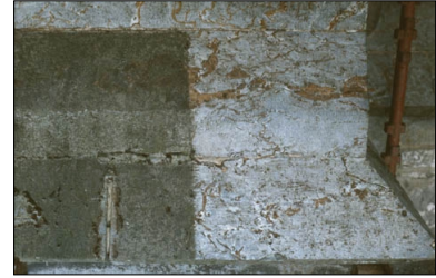
Dekk på pillar på nordsiden av koret. Prøvefelt for vasking med vann og myke børster. Vi ser at strukturen i steinen trer tydelig frem etter vasking.
