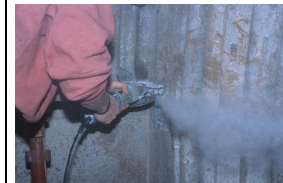
Endel av utmeislingen gjøres ved hjelp av vinkelsliper
