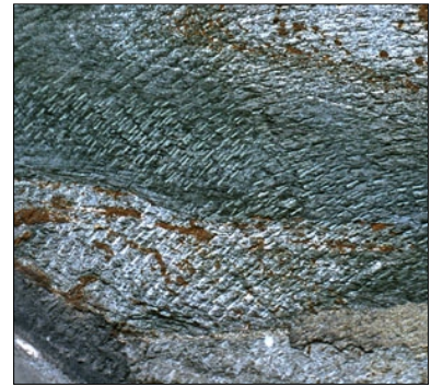
Grov etterhugging av kvaderflater
