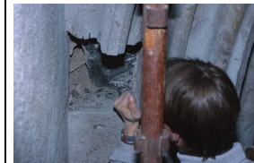
Siste del av utmeislingen gjøres for hånd. Det viser seg at murkjernen har lite bindemiddel
