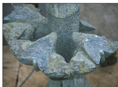
Bjørnåkleber forvitrer lett, noe vi kan se på denne fialen eller korsblomsten fra 1920 på sørfasaden
