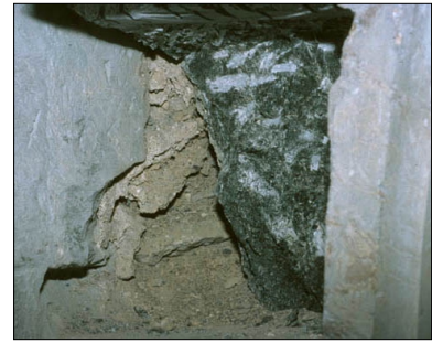
Sett inn i murkjernen ved detalj nr. 89 på nordveggen. Ornametet ble hugget ut for innsetting av nytt, og tørr sand fra murkjernen raste ut.
