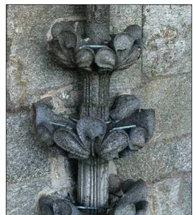
Kobberklemmer fra 1920 benyttet for å styrke korsblomster
