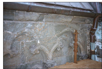
Forvitring på østre del av sørveggen
