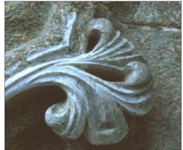
Ornament på sørveggen rekonstruert ("flikket") med Billys steinlim tilsatt steinstøv (nr. S49)
