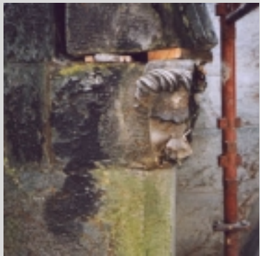
Dene ene delen av hodet ble først demontert langs kløvsprekken
