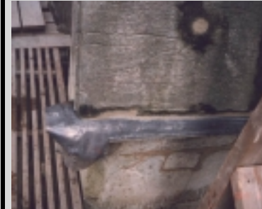
Hodet og pillar- gavlen er montert tilbake på plass. Blybeslag montert over hodet
