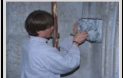
Ny stein prøveoppsettes og monteres senere med 4 mm syrefast stål og kalkmørtel
