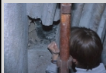
Siste del av utmeislingen gjøres for hånd. Det viser seg at murkjernen har lite bindemiddel
