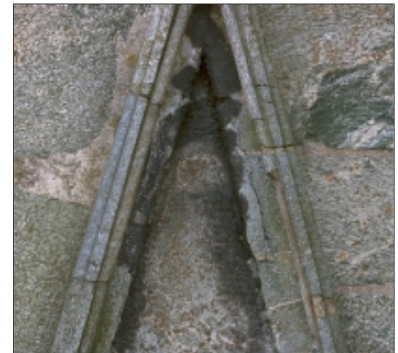
Sorte skorper under gavldekk på østveggen
