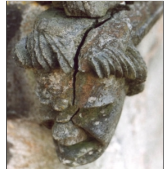
Kløvsprekk i Stavangerkleber. Ingen rustende dybler i dette tilfellet!.
