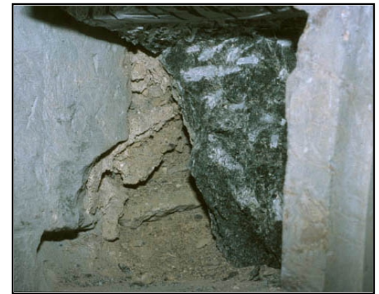
Sett inn i murkjernen ved detalj nr. 89 på nordveggen. Ornamentet ble hugget ut for innsetting av nytt, og sand fra murkjernen raste ut.
