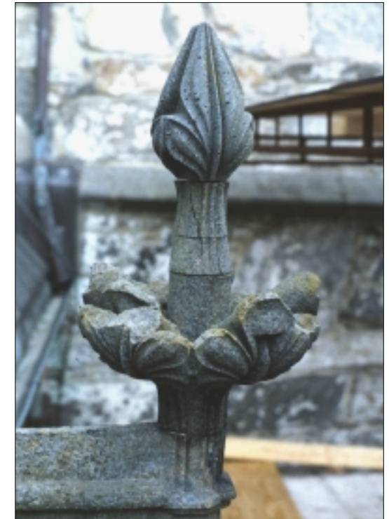
Bjørnåkleber på sørsiden av koret. "Stilken" er sprukket opp pga. for store dybler, mens bladene er sprukket eller forvitret bort uten dybler tilstede.
