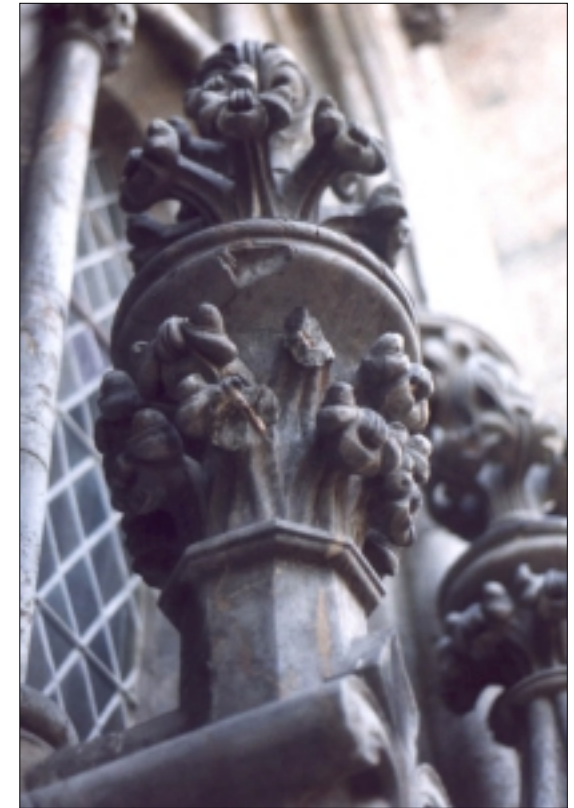
To rustende jerndybler har medført at ornamenter har sprukket og falt av. Fial over Sørportalen.
