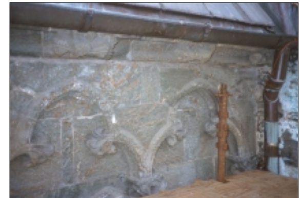
Forvitring på østre del av sørveggen
