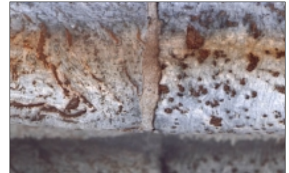
Brunrøde og litt oppløste aggregater og årer av dolomitt eller magnesitt ("kalk") i Stavangerkleber.
