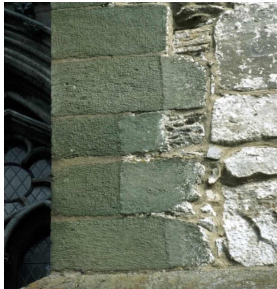
Hjørnekvadre av grønnskifer på søndre kortårn. Deler som ikke lå under kalkpuss er etterhugget omkring 1870.
