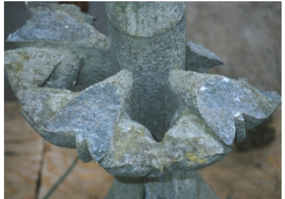
Bjørnåkleber forvitrer lett, noe vi kan se på denne fialen fra 1920 på sørfasaden
