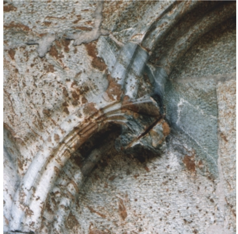
Stavangerkleber på sørsiden av koret. Vi ser at lyse partier med rustbrune karbonatårer finnes i stein som også har grønne partier
